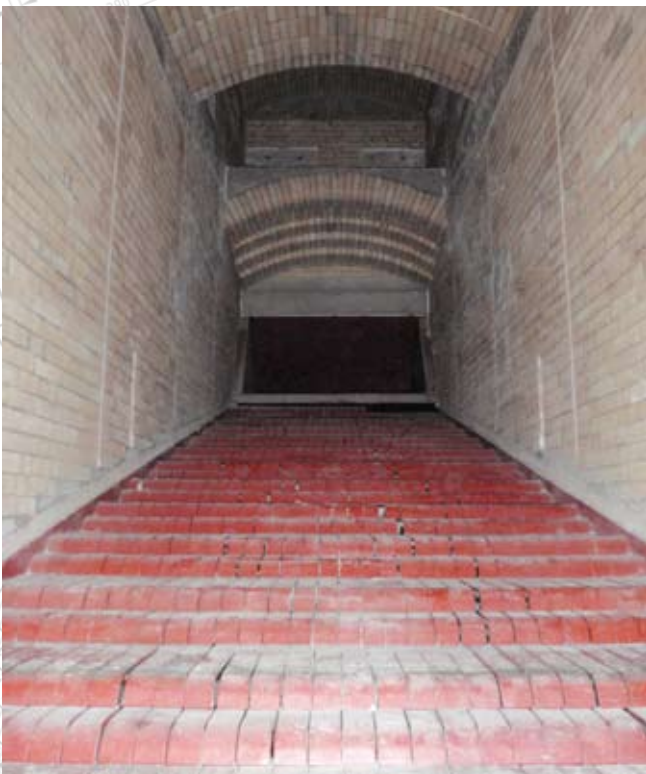
Blick auf den Rost nach Montageende
