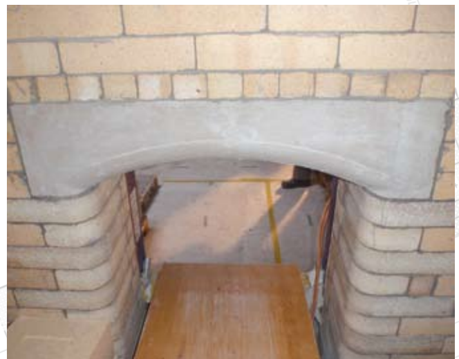
Sauber durchdachte Konstruktion und Ausführung im Bereich der Einstiegstüre
