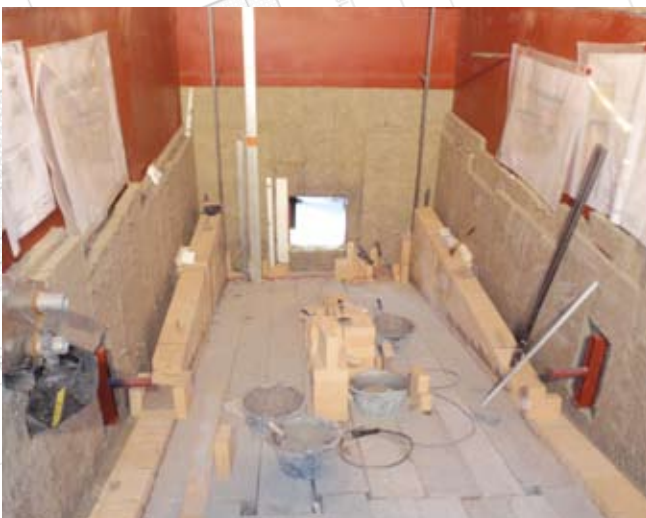
Aufbau der Wände mit Dämmung
