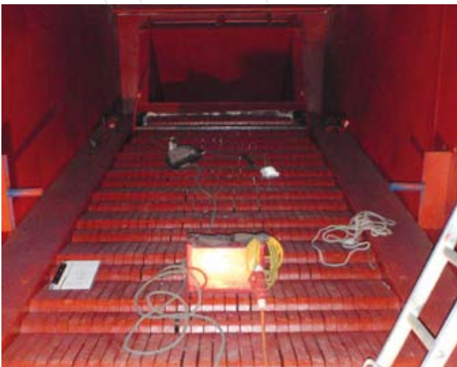
Blick auf den Rost der feuerfesten Ausmauerung vor Montagebeginn
