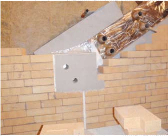
Wanddetail im Bereich der Luftkästen
