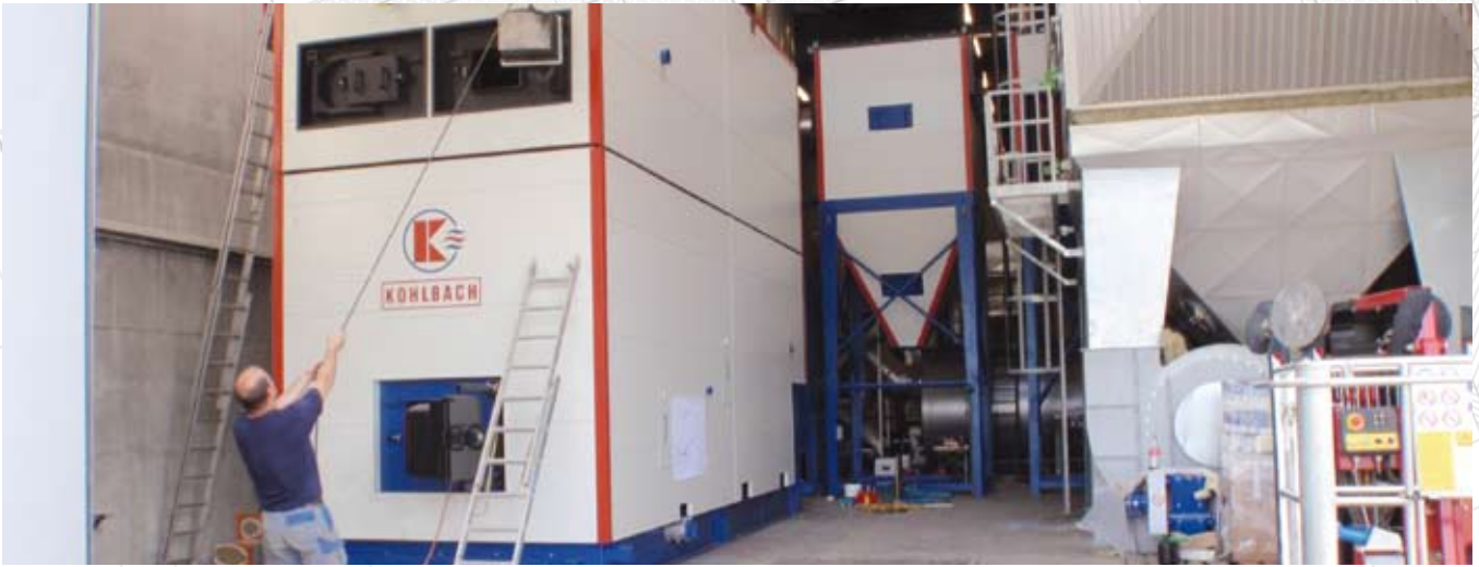
Die Montage der Kesselanlage in Modulbauweise
