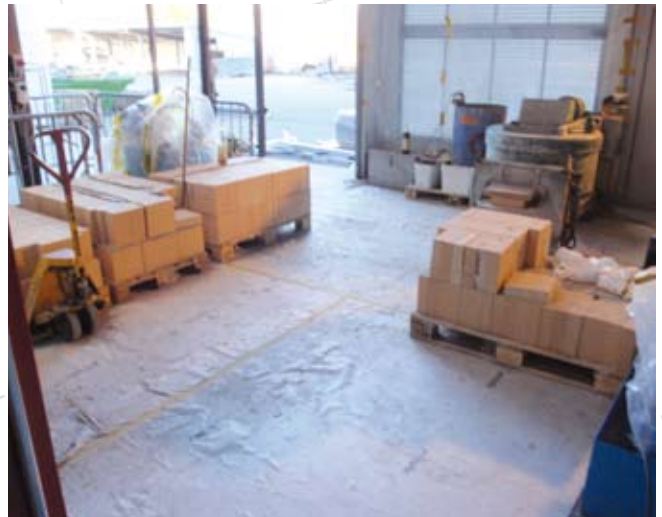
Eine Bauplatzinstallation, die man zeigen darf
